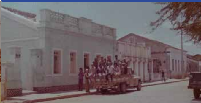
Casa onde funcionou a ECR (1975-1994)
