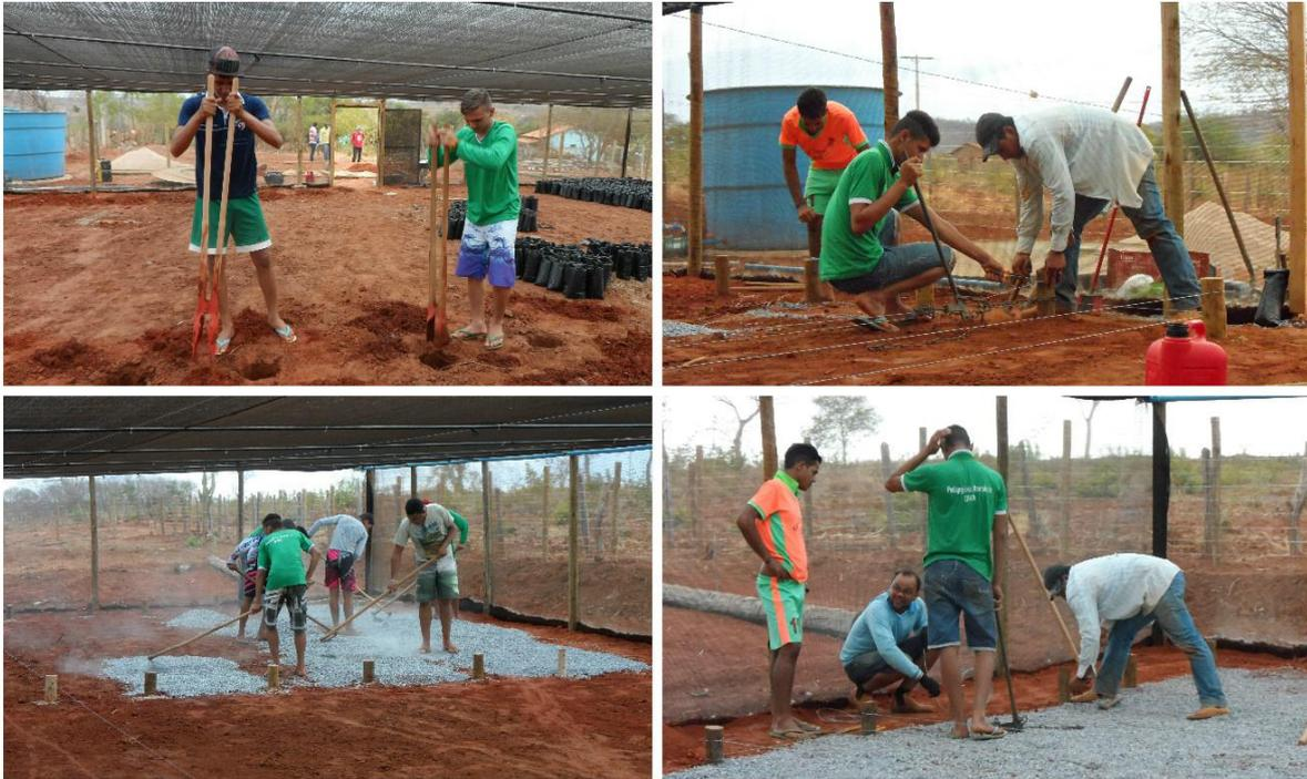
Figura 2. Construção dos canteiros e forração com brita.
